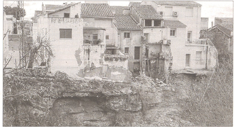
Imatge d'arxiu de l'estat en què van quedar les cases del barranc de la Galera. FOTO: JOAN REVILLAS
