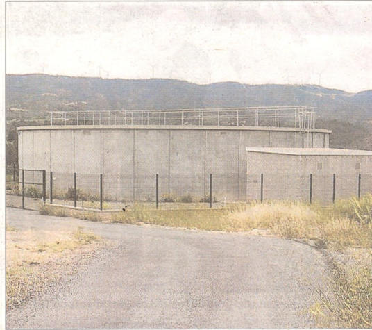
Imatge del gran dipòsit d'aigua construït al municipi d'Ascó en el marc de les obres d'abastament alternatiu i que encara està buit. FOTO: JOAN REVILLAS
