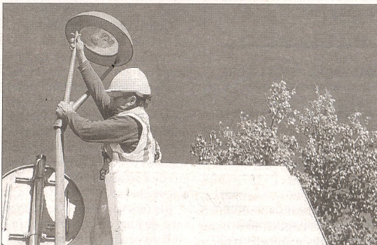
Els operaris de l'empresa adjudicatària del servei estan canviant aquests dies les làmpades de places i carrers. FOTO: JOAN REVILLAS
