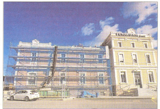
Estat dels treballs de millora de la façana i coberta de l'estació de Móra la Nova, ahir al migdia. FOTO: JOAN REVILLAS
