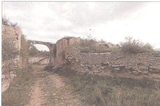
L'antiga fortificació està molt abandonada i requereix una intervenció per consolidar les estructures. FOTO: JOAN REVILLAS
