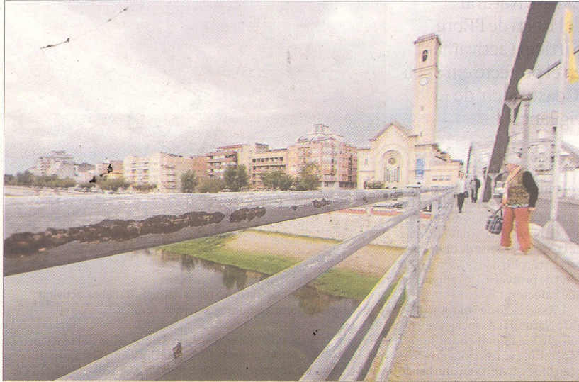
Imatge de les baranes del pont de l'Estat sobre el riu Ebre a la ciutat de Tortosa, ahir. FOTO: JOAN REVILLAS
