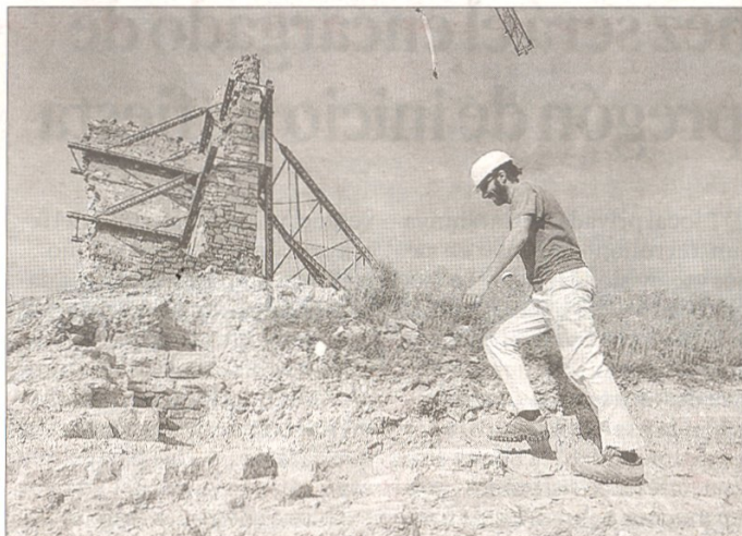
Estat de ruïna de l'estructura de la fortalesa del municipi riberenc.
