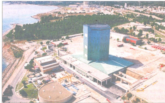
Vandellòs I abans i després del desmantellament. / ENRESA
