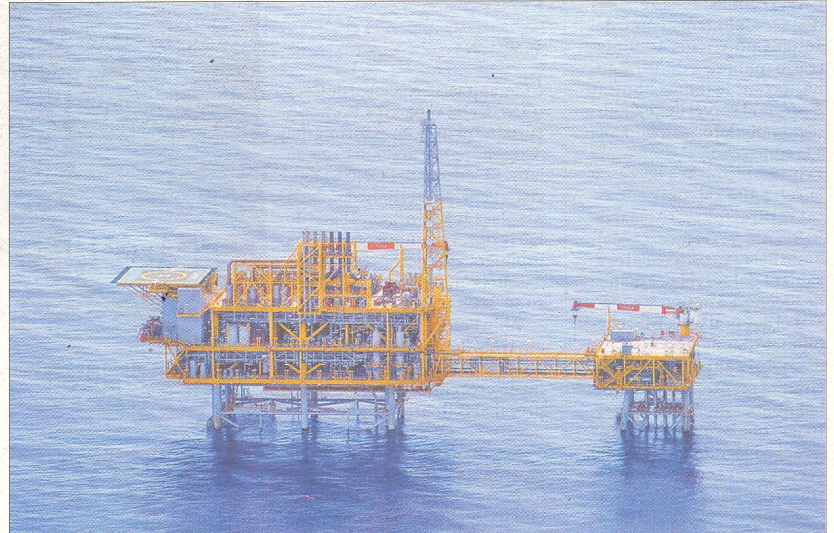
Plataforma marina del projecte Castor, davant la costa d'Alcanar i Vinaròs. FOTO: JOAN REVILLAS
