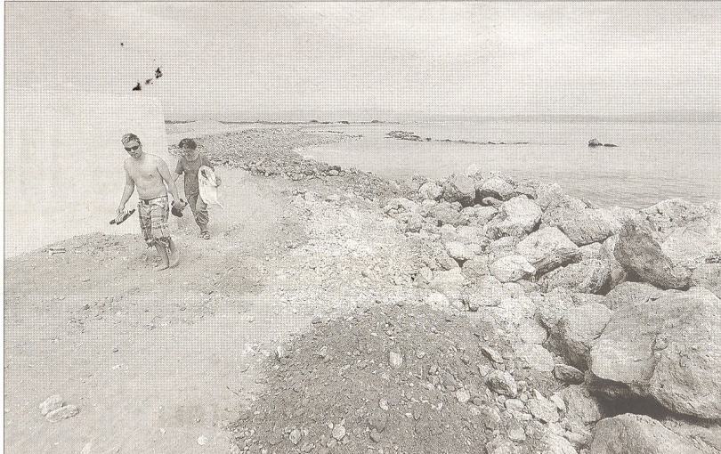
Estat actual de la carretera d'accés al Fangar, impracticable per als vehicles. FOTO: JOAN REVILLAS
