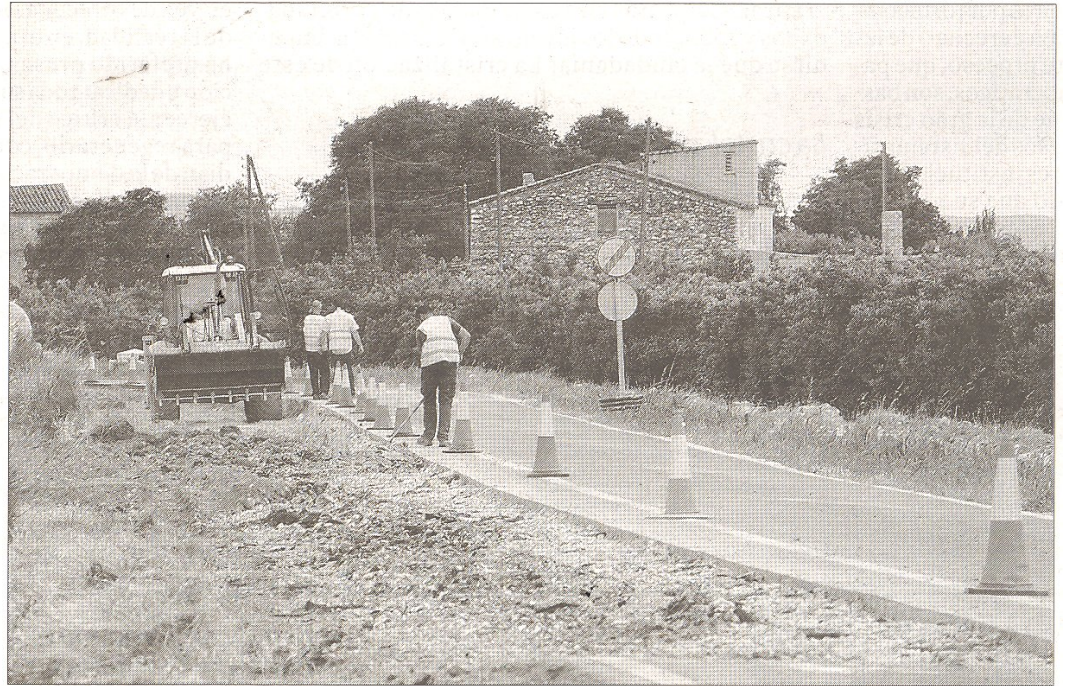
Operaris i màquines treballant a la carretera de Bítim. FOTO: JOAN REVILLAS
