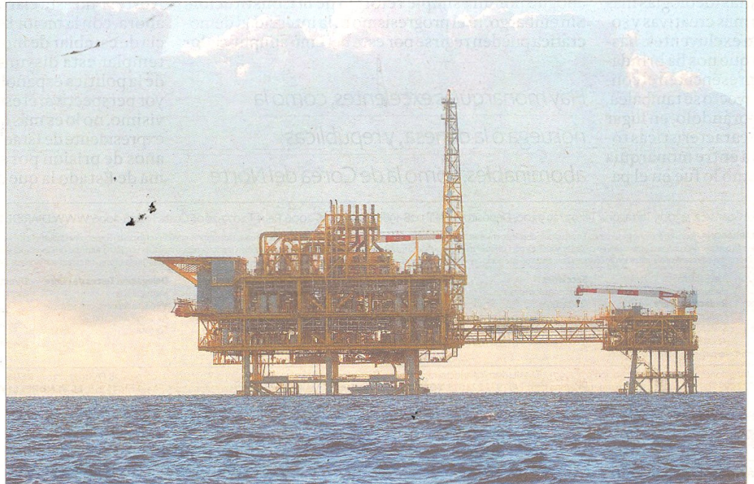
La plataforma marina del projecte Castor. FOTO: JOAN REVILLAS
