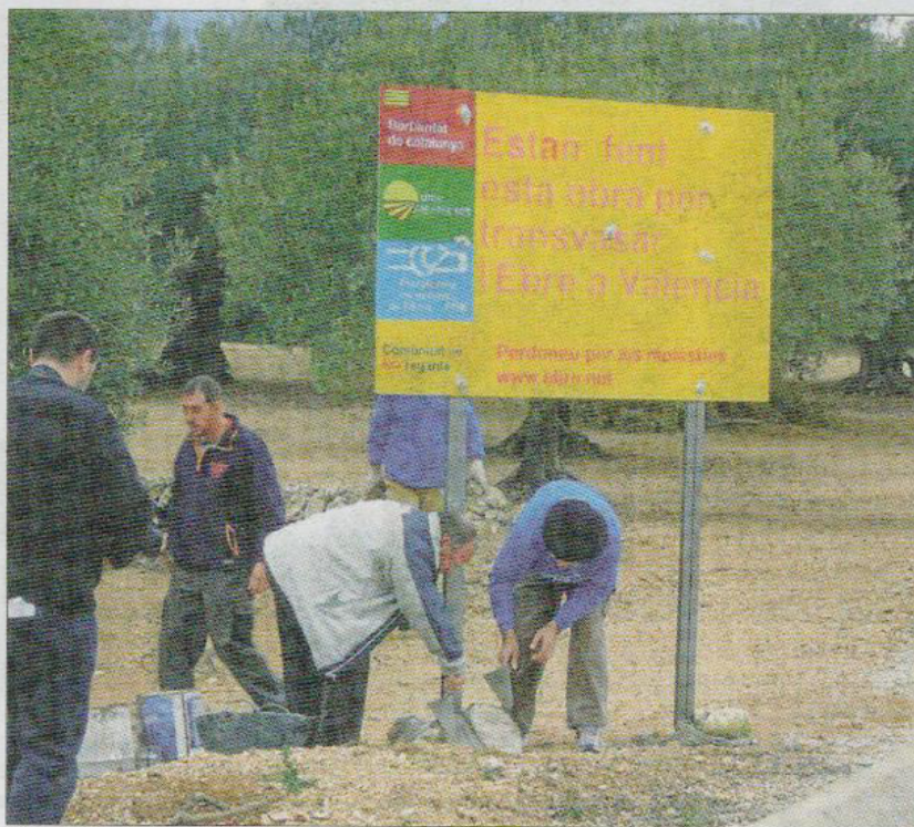
Membres de la PDE i Unió de Pagessos col·locant un cartell per denunciar les obres del canal de regadiu Xerta-Sénia, en una imatge d'arxiu ■ L. MORESO
