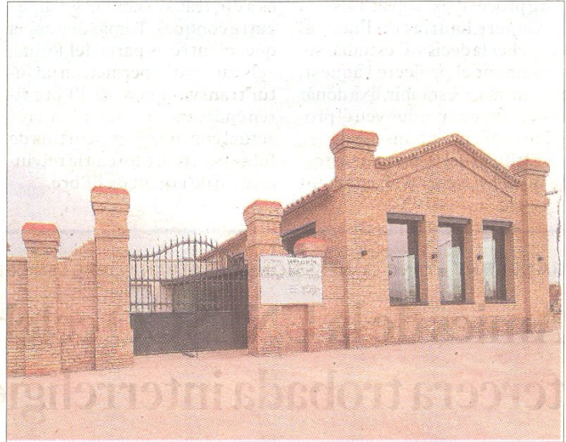
Les obres del nou tanatori de Móra la Nova ja estan acabades.
