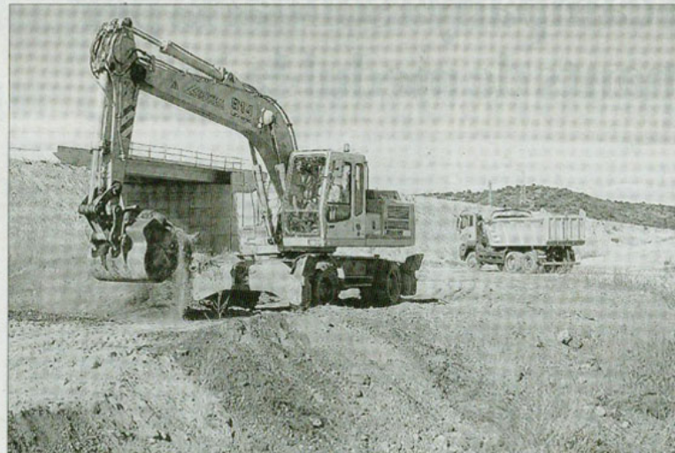
Una de les dues màquines excavadores que ahir van reprendre les obres de la variant. FOTO: A. CARALT
