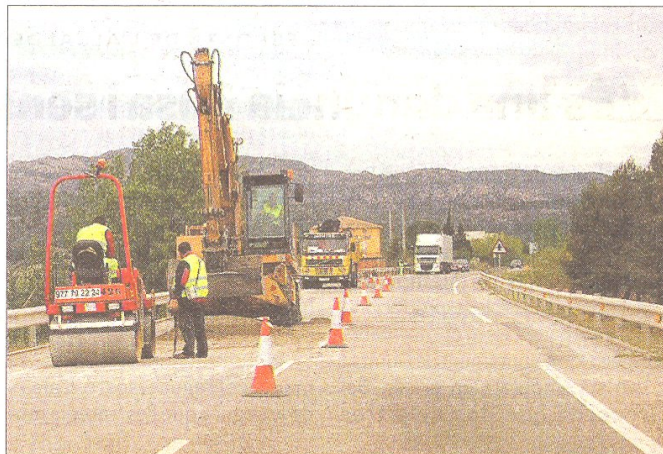
Un dels petits trams d'asfalt arranjats a l'altura del municipi de Xerta, a la comarca del Baix Ebre. FOTO: JOAN REVILLAS
