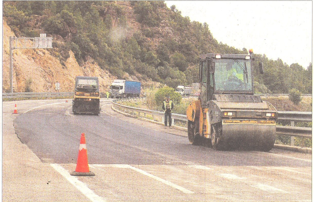
Imatge dels treballs de manteniment al terme de Benifallet. FOTO: JOAN REVILLAS
