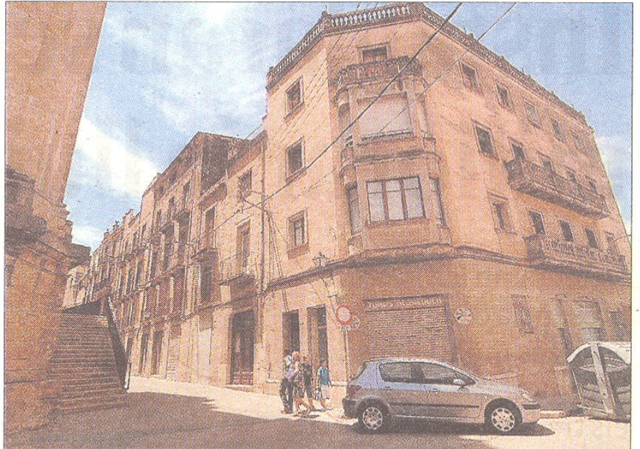
Imatge de les cases del carrer Croera, situades davant de la façana de la Catedral, pendents d'enderroc. FOTO: J. REVILLAS
