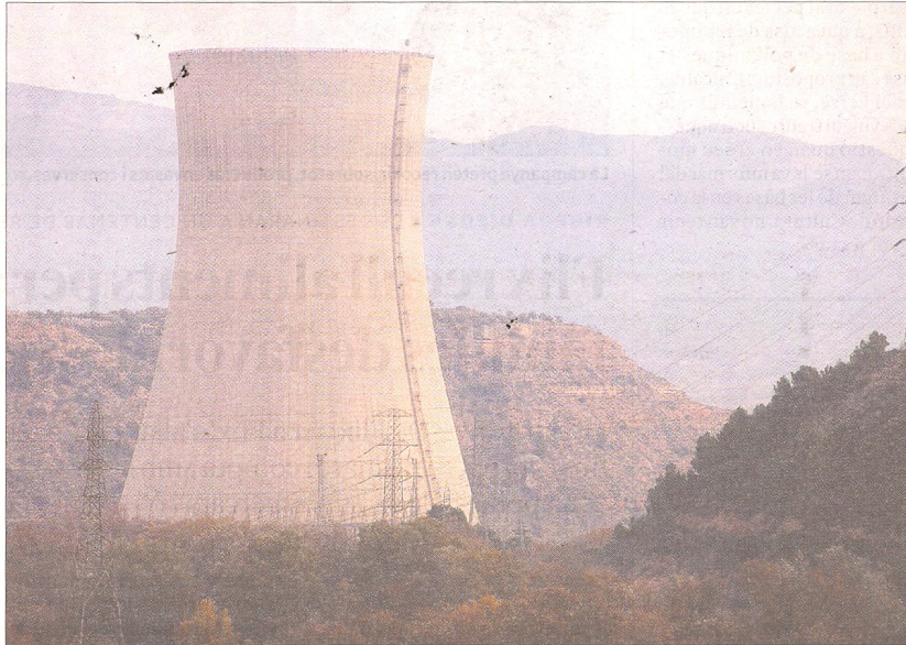
Imatge de la torre de refrigeració del complex nuclear d'Ascó. FOTO: JOAN REVILLAS
