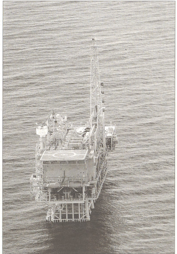
Vista des de l'aire de la planta marina del projecte Castor, davant la costa d'Alcanar. FOTO: JOAN REVILLAS
