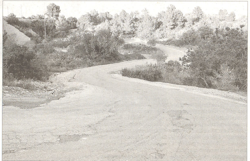
Camí asfaltat que creua actualment el barranc de Santes Creus, a l'Ametlla de Mar. FOTO: JOAN REVILLAS
