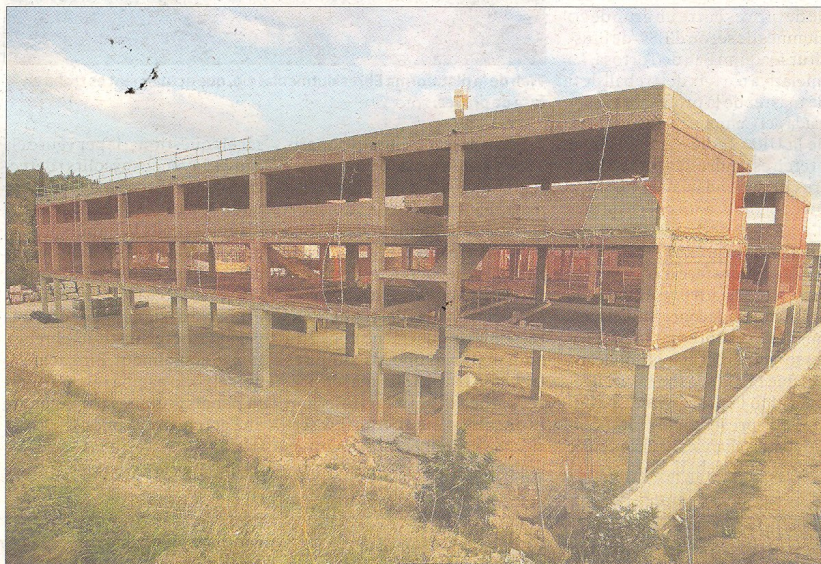
Estat actual de les obres a la nova escola de Sant Llàtzer. FOTO: JOAN REVILLAS
