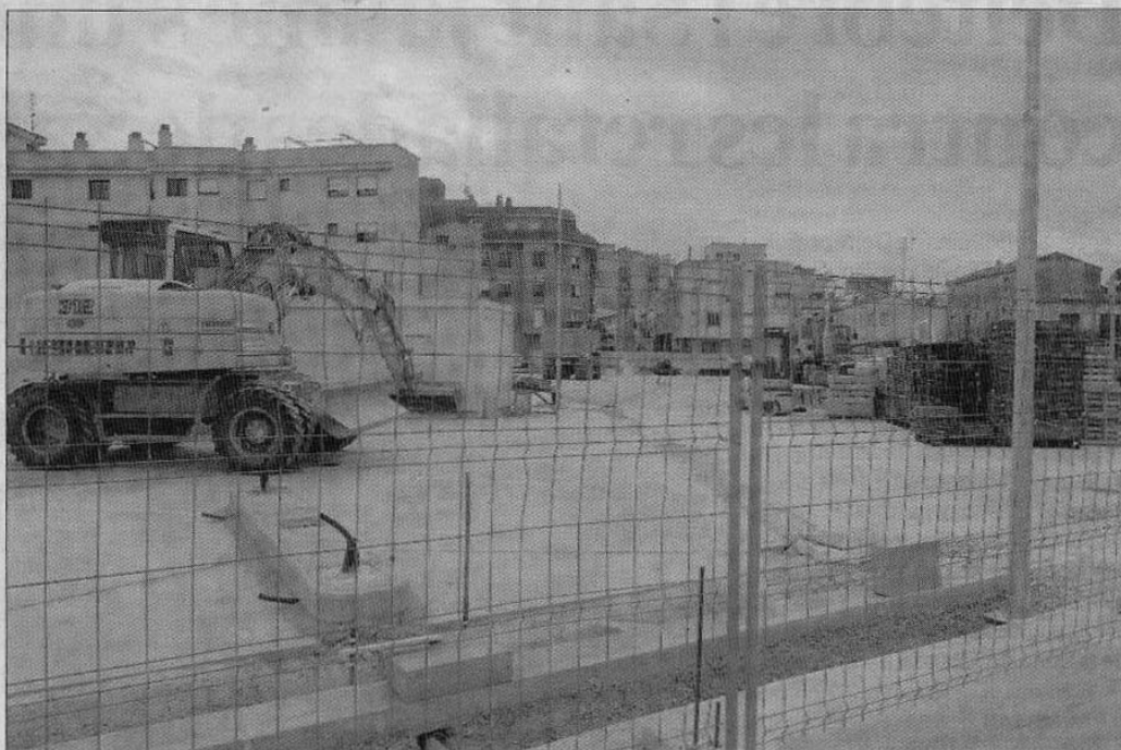
■ Maquinària treballant en l'adequació de les noves places d'aparcament. FOTO: JOAN REVILLAS
