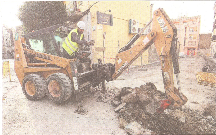
Treballs al carrer David Ferrando, aquesta setmana. FOTO: JOAN REVILLAS
