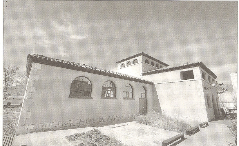
La nova oficina de turisme i centre d'interpretació s'ubicarà a l'edifici rehabilitat de l'escorxador. FOTO: J. REVILLAS
