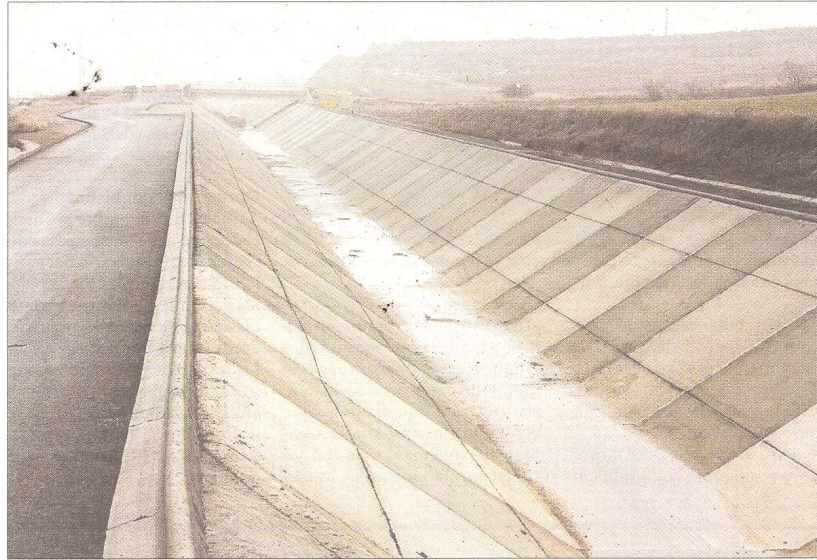
Un tram del canal principal del Segarra-Garrigues, ja construït. FOTO: ACN
