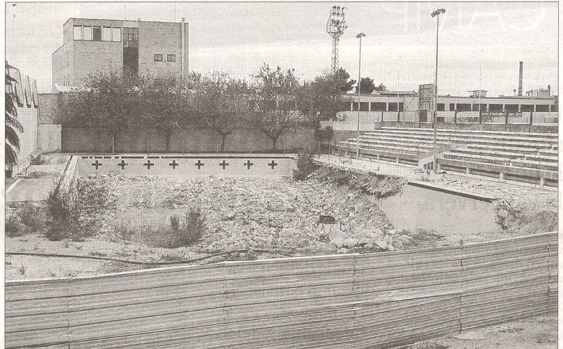
Aquest és l'estat de l'antiga piscina descoberta, a l'espera de la construcció del nou complex d'aigües. FOTO: DT
