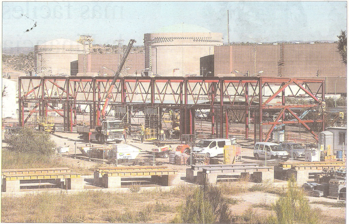
Imatge de l'estat de construcció del magatzem que acollirà els equips portàtils d'emergència. FOTO: ANAV
