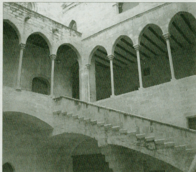
Les obres són al pati interior d'aquest palau. / ARXIU
