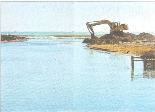
Maquinària pesada retirava ahir al migdia sorra a la platja de l'Eucaliptus per facilitar l'entrada d'aigua del mar als desguassos. FOTO: JOAN REVILLAS
