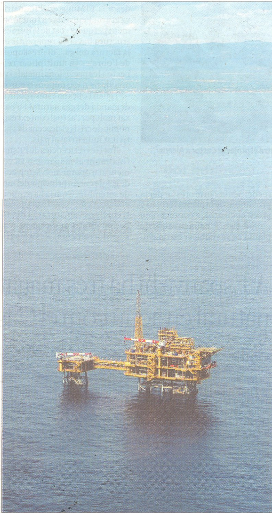
La planta marina del magatzem de gas Castor, davant la costa de Vinaròs i Alcanar. FOTO: JOAN REVILLAS
