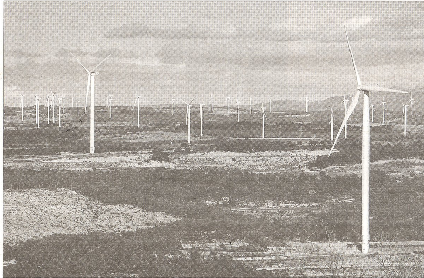
Imatge de l'actual implantació massiva d'aerogeneradors a l'altiplà de la Terra Alta. FOTO: JOAN REVILLAS
