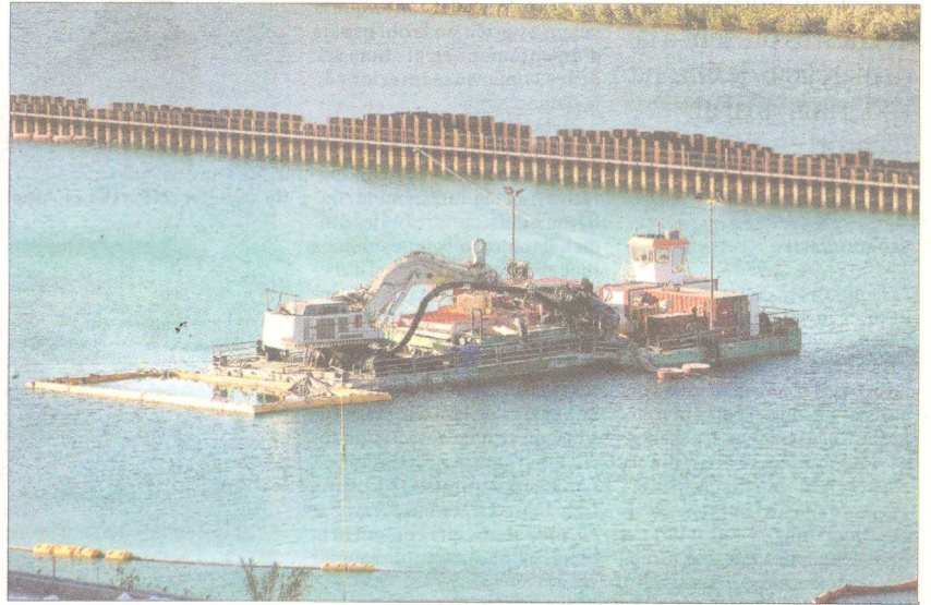
La draga extraient llots contaminats, ahir a la tarda al pantà de Flix. FOTO: JOAN REVILLAS
