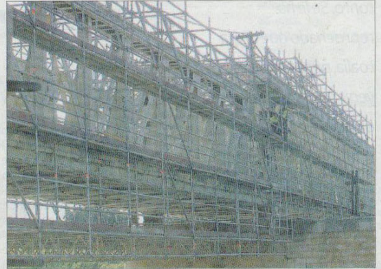
► Una gran bastida cobreix actualment bona part de l'antic pont del ferrocarril. FOTO: JOAN REVILLAS
