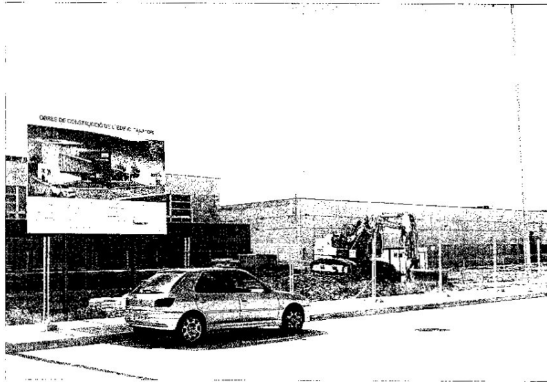
Obres de construcció del nou tanatori, a la zona dels Portals de Ciutat. FOTO: JOAN REYES LLAS
