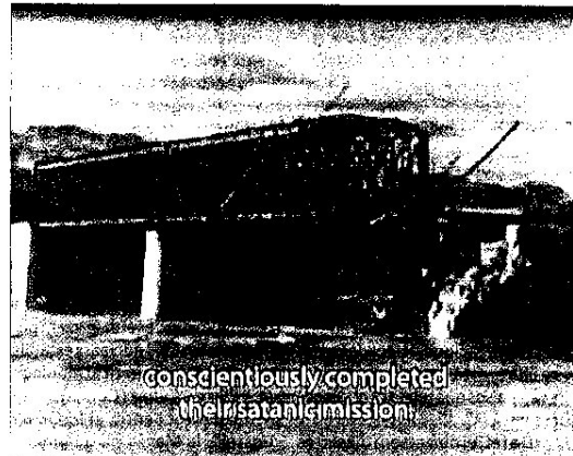
Imatge del pont del ferrocarril de Tortosa, destruït per les forces republicanes el 19 d'abril de 1938. FOTO: MO-DO
