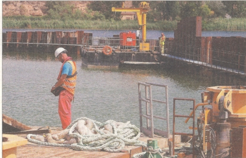
Un operari, ahir al matí, treballant al costat del mur de contenció aixecat al pantà de Flix. FOTO: JOAN REVILLAS
