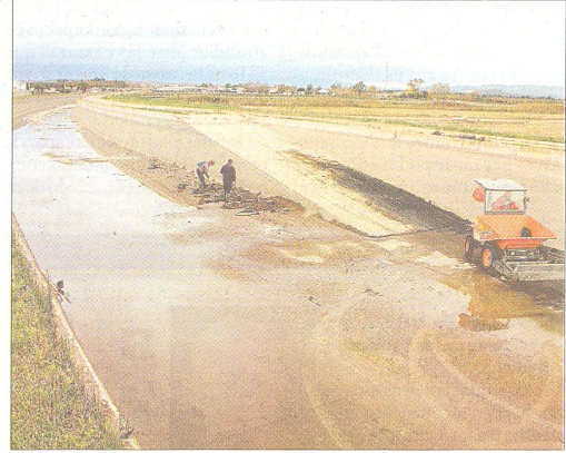
Operaris de la Comunitat de Regants de la Dreta, treballant ahir en la recerca de caragols poma al canal. FOTO: ACN
