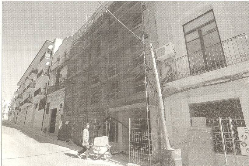
El nou centre cívic, l'única obra en marxa. - La construcció del centre cívic és actualment l'única obra en marxa de la Llei de Barris. Tot i que estava previst finalitzar les obres aquest estiu, la construcció no és culminarà fins al desembre. El centre cívic comptarà amb una sala polivalent per oferir xerrades. Les obres han permès també arranjar la teulada de l'ajuntament, ubicat al costat, una obra no prevista en un inici. FOTO: J.R.
