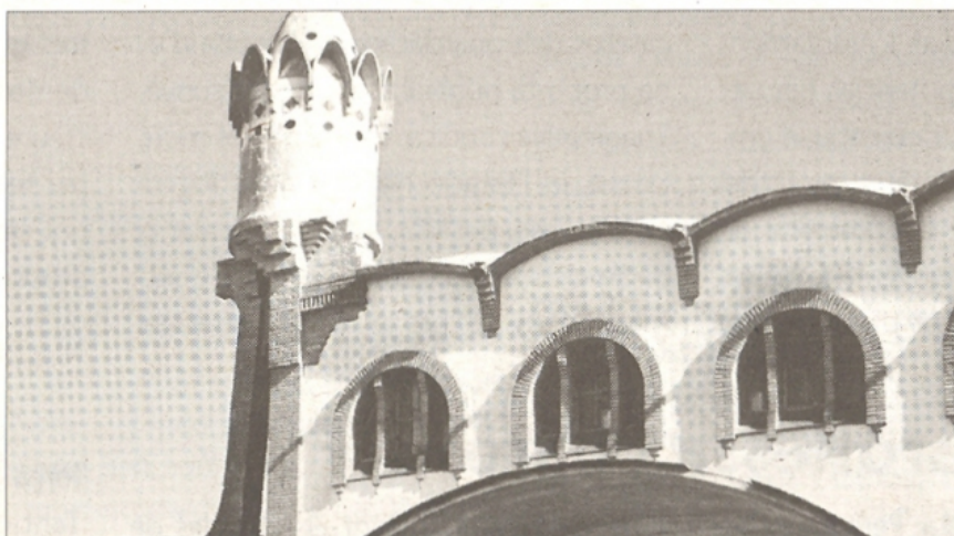
El celler cooperatiu de Gandesa s'està rehabilitant.
