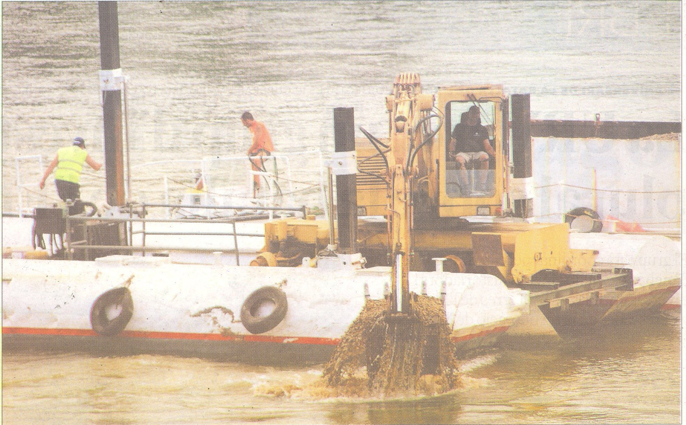
Draga extraient terres i sediments del fons fluvial, aquesta setmana a Tortosa. FOTO: ANDREU CARALT
