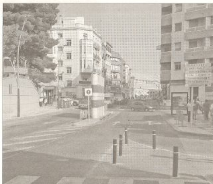
Aquesta és la vista de l'avinguda de la Generalitat sense pont. / V. BORJA
