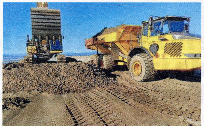
Moviments d'arenes en marxa per reforçar les parts més afeblides de l'istme. FOTO: SUBDELEGACIÓ DEL GOVERN A TARRAGONA
