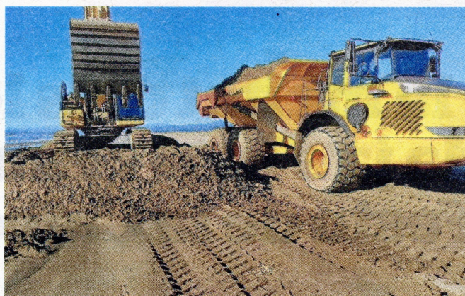
Moviments d'arenes en marxa per reforçar les parts més afeblides de l'istme. FOTO: SUBDELEGACIÓ DEL GOVERN A TARRAGONA
