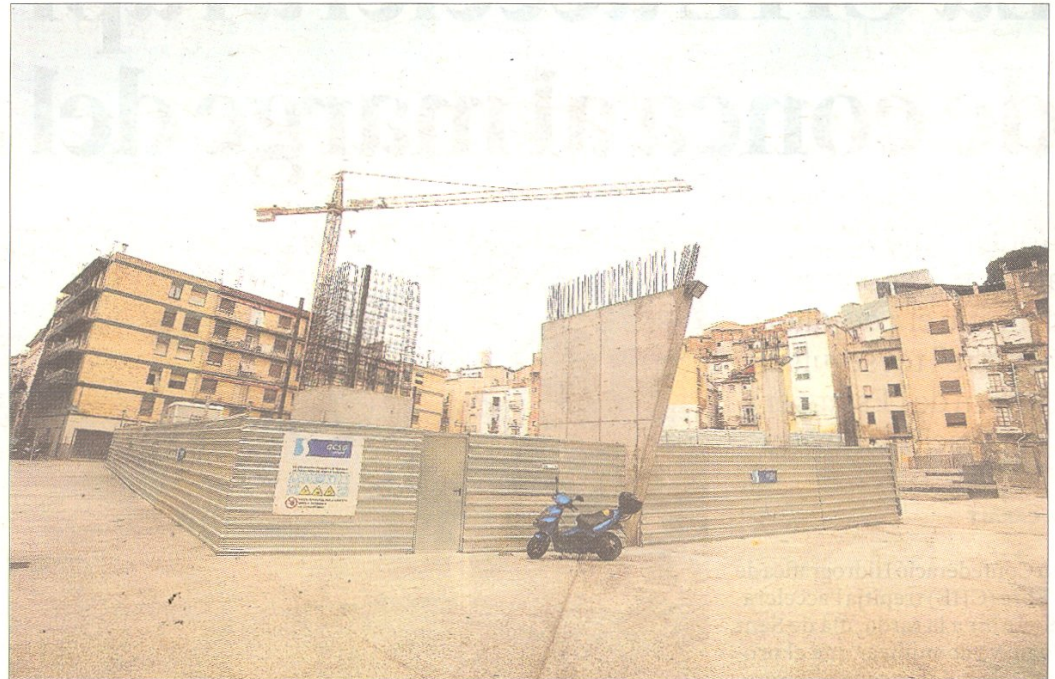
Imatge actual de l'estat del complex de l'edifici de les delegacions i l'aparcament soterrat. FOTO: JOAN REVILLAS
