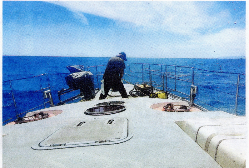
Treballs des de l'embarcació d'inspecció marítima. FOTO: DEPARTAMENT D'ACCIÓ CLIMÀTICA
