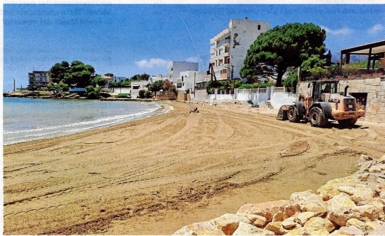
Una màquina de Costes durant els treballs per reforçar la platja del Suís de la Ràpita. FOTO: CEDIDA
