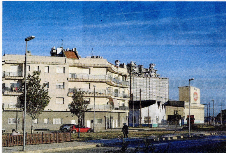
Les instal·lacions de la Càmara Arrossera, a la ciutat d'Amposta. FOTO: JOAN REVILLAS
