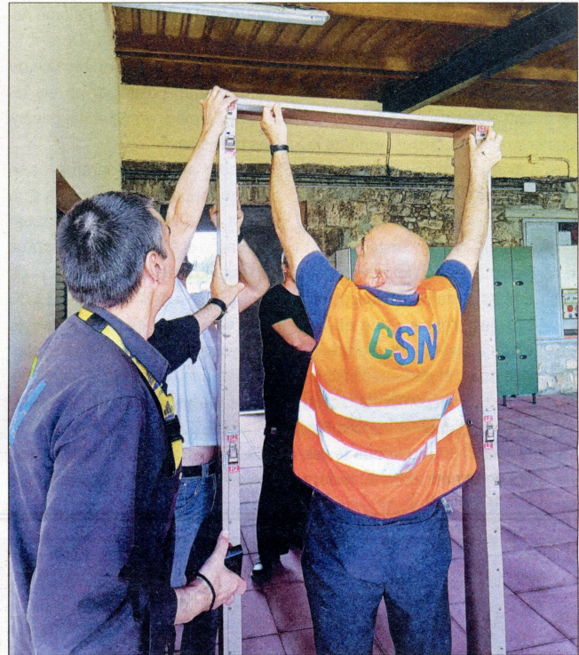
Instal·lació d'un de tres aparells de cribratge nuclear./CEDIDA
