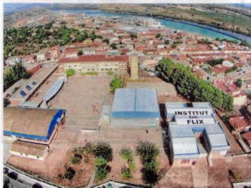
Vista aérea del Institut de Flix antes de retirar la cubierta. FOTO: CEDIDA
