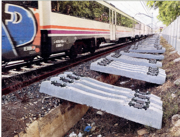
Travesses preparades per a instal·lar ample europeu al ramal de Tortosa.
