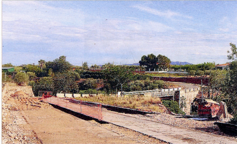
Estat actual de les obres de rehabilitació del pont sobre el barranc de Vall Cervera, als Reguers. / PAULA VIDAL
